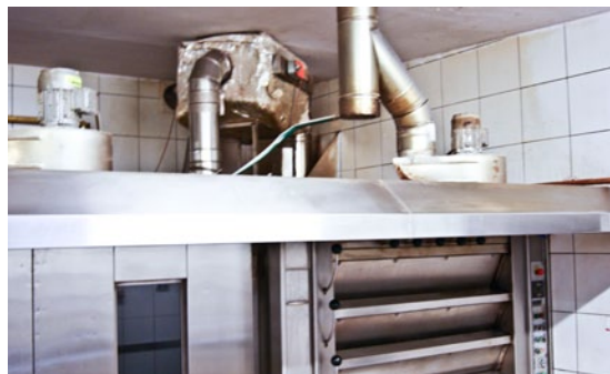
Ciepło z największego pieca w piekarni ogrzewa wodę w kaloryferach i wodę użytkową w firmie i mieszkaniu. Jak przyznaje Piotr Koperski, system odzysku ciepła to jego najlepsza inwestycja
