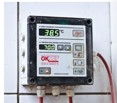
Ciepło z największego pieca w piekarni ogrzewa wodę w kaloryferach i wodę użytkową w firmie i mieszkaniu. Jak przyznaje Piotr Koperski, system odzysku ciepła to jego najlepsza inwestycja
